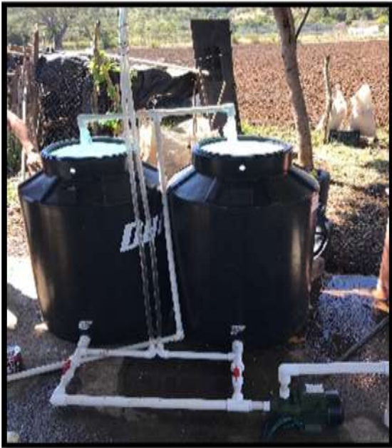
Figura 19. Instalación del sistema de riego.
