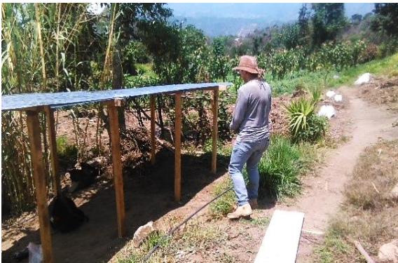
Fotografía 3: Elaboración de locales para almacenamiento de abonos orgánicos.
