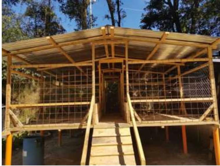
Figura 1. Construcción de instalaciones.
